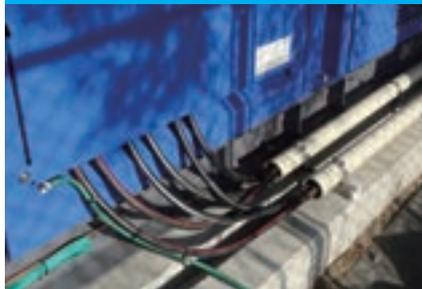
発電機と、設置する施設の電源との配線工事を行います。
