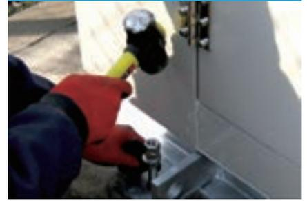
アンカーボルトを打ち込み、発電機を基礎に固定します。
