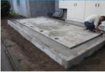
発電機を固定する基礎を設置します。
