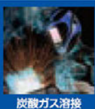
炭酸ガス溶接
