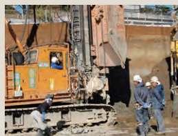
地盤改良工事に
