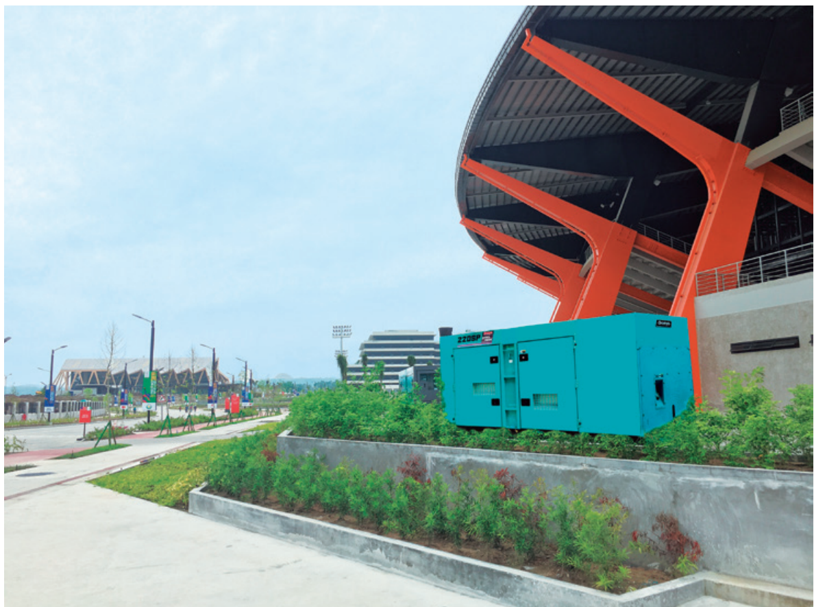
第30回東南アジア競技大会（フィリピン）で使用された発電機
