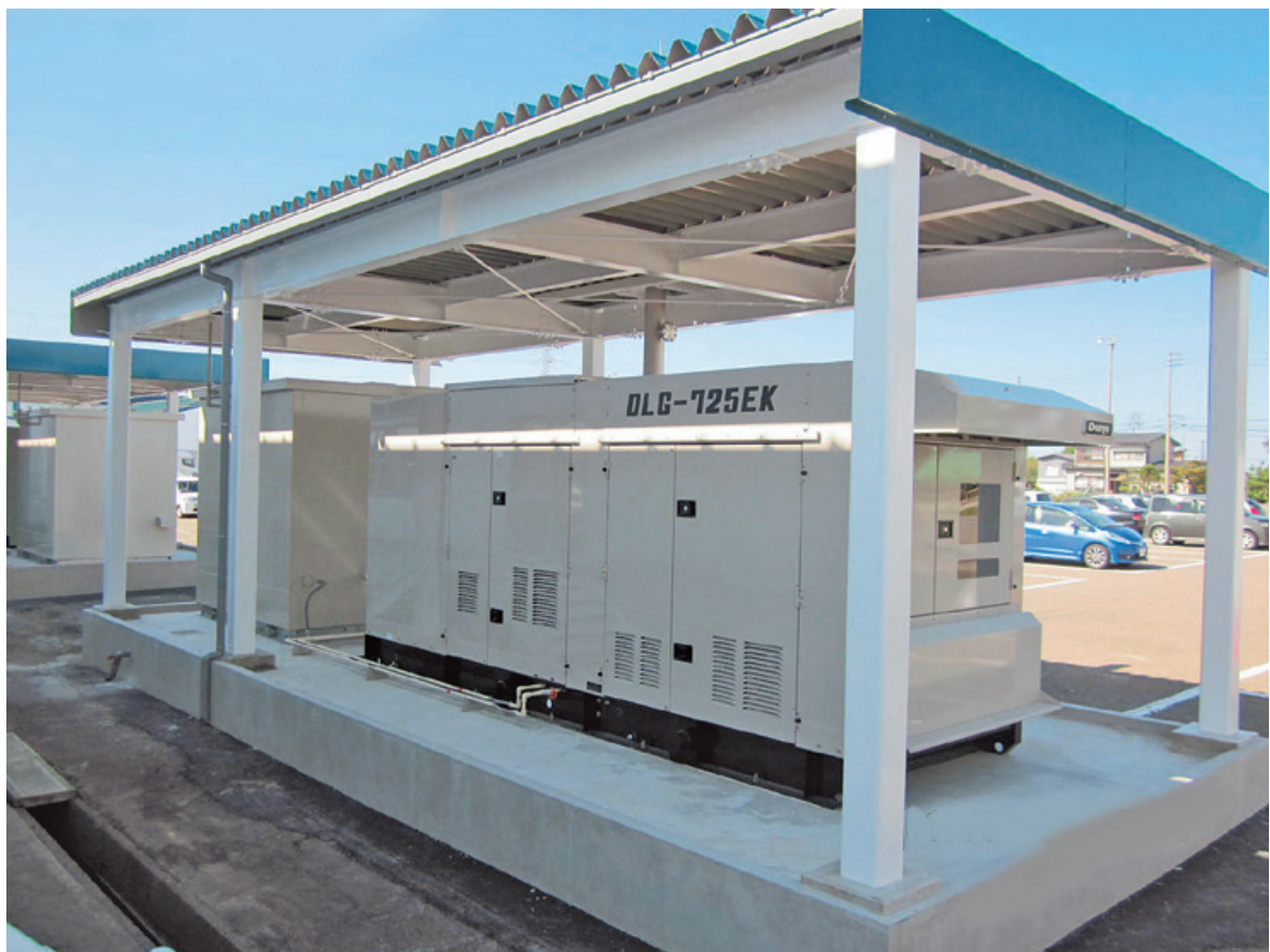
工場で使用する電力のピークカットに貢献する発電機
