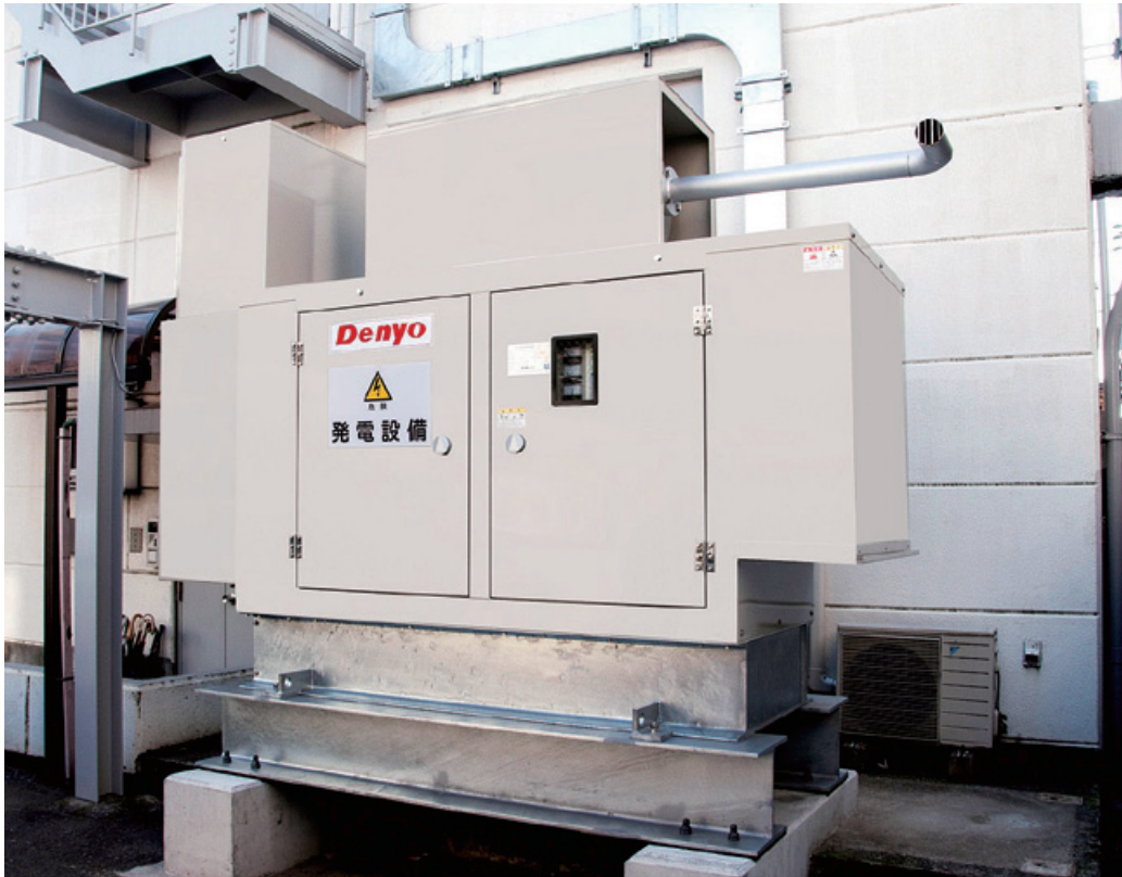
銀行に設置されている防災用自家発電装置
