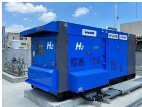
コマツ 小山工場に導入した水素混焼発電機
