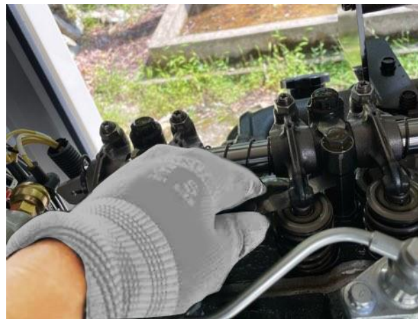
発電機のエンジン調整
