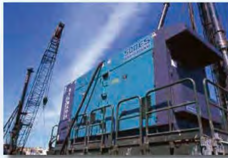
Como fuente de alimentación en el sitio de construcción.
