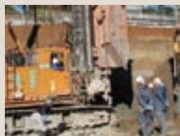
地盤改良工事に
