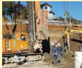
地盤改良工事に
