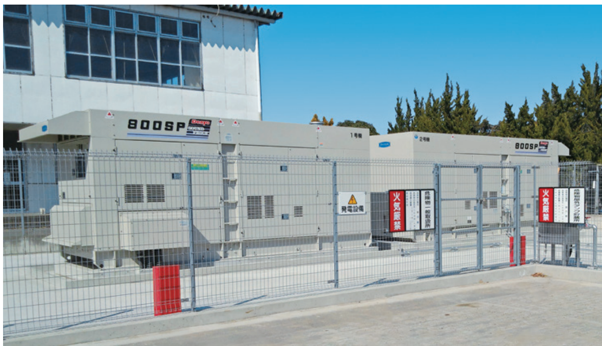
ショッピングセンターに設置されている非常用発電機
