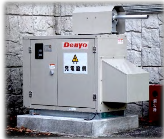
ホテルに設置されている防災用自家発電装置
