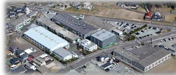
西日本発電機
