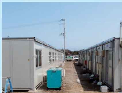
仮設住宅用の電源として使用されている エンジン発電機
