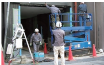
（外装工事に使用される高所作業車）
