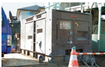
（住宅基礎工事に使用されるエンジンコンプレッサー）
