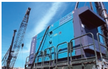
（基礎工事に使用されるエンジン発電機）
